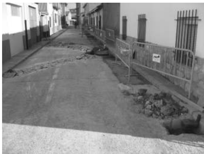
Obras en la calle Reina Doña Sancha
