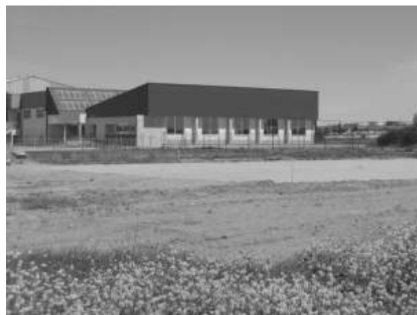
Pista polideportiva en el Colegio.
