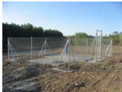
Nueva captación de agua
