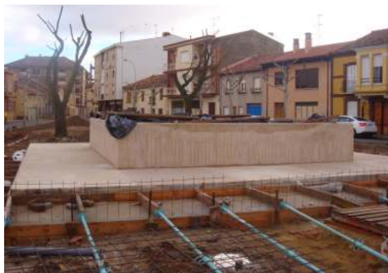
Obras Plaza Santa Marina
