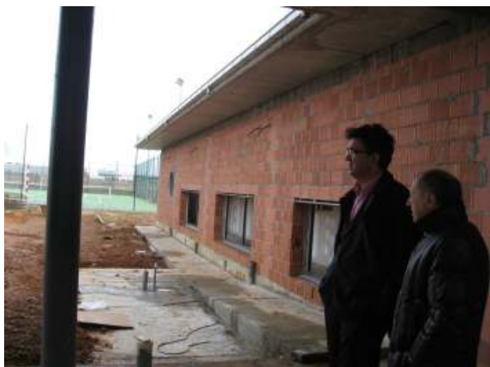
Obras de la guardería
