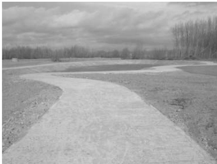
Construcción del paseo alrededor de los lagos.
