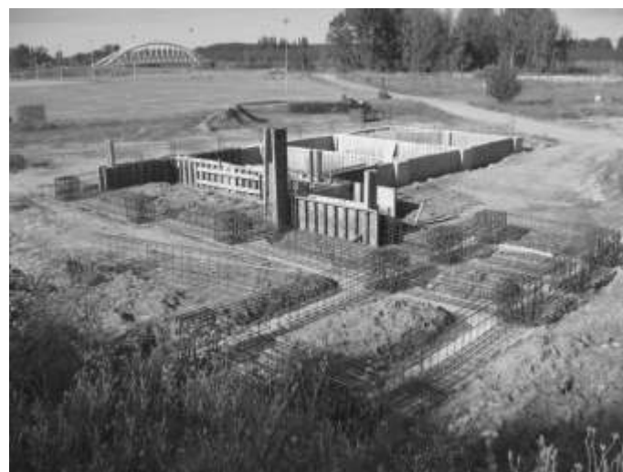
Obras Edificio de La Condesa en el Complejo La Isla.
