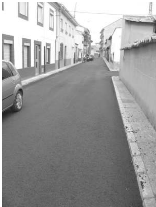
Hormigonado calle Sancha..
