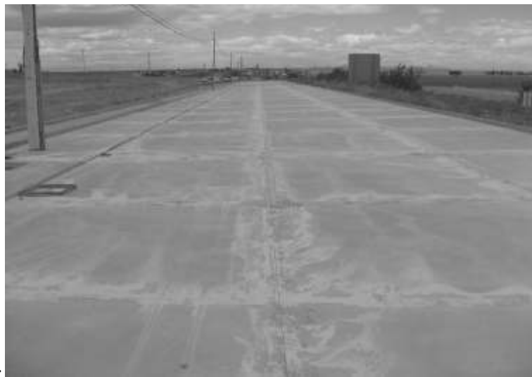
Hormigonado vial polígono industrial.
