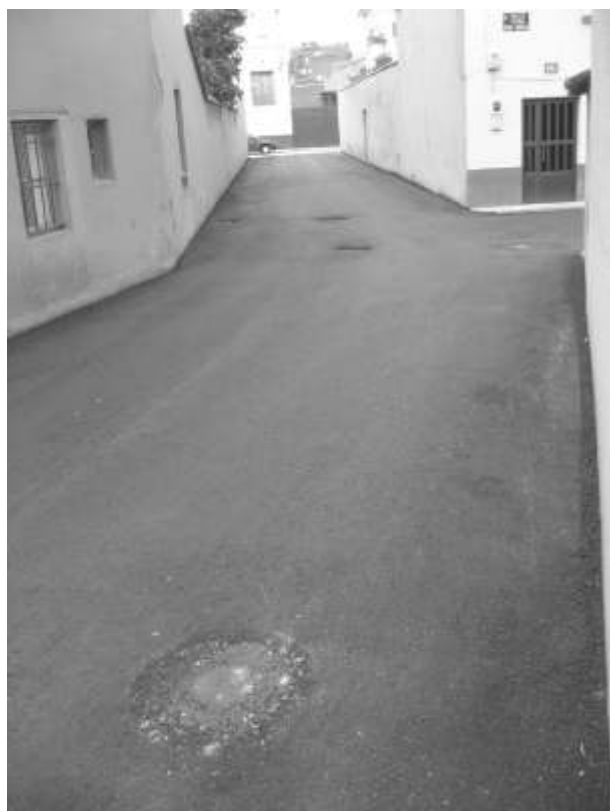
Asfaltado calle Falla.
