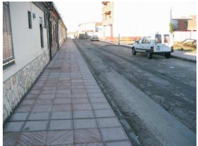
Sustitución aceras Avda. Constitución.
