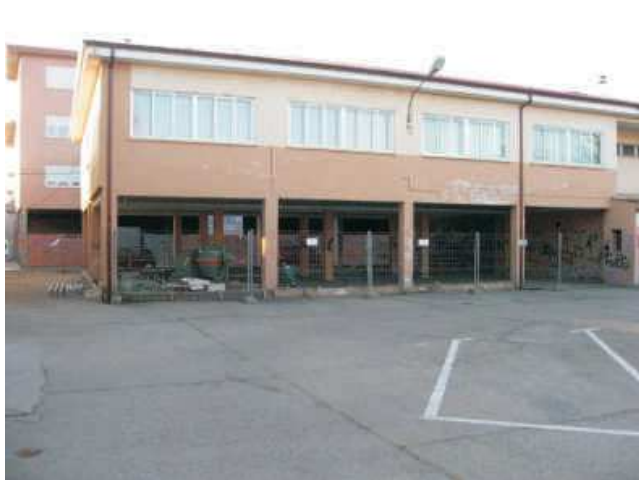
Obras edificio C/ Alonso Castrillo
