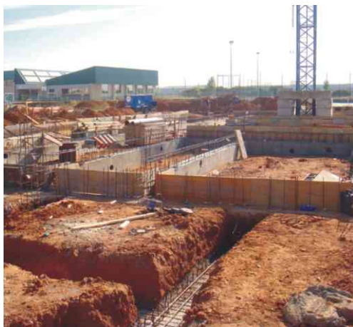
Obra de la guardería
