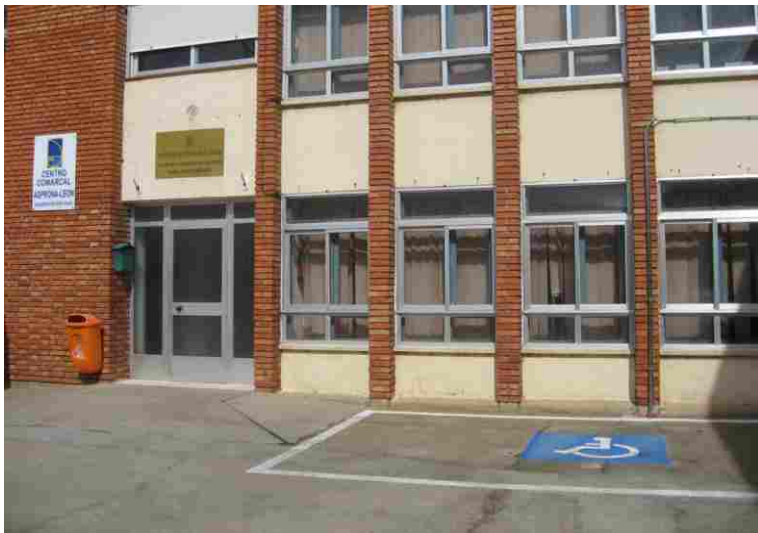
Aparcamiento calle Luis Alonso
