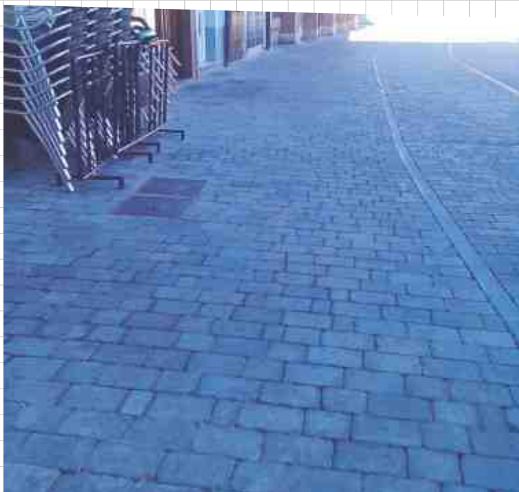
Sustitución de adoquines en la Plaza Mayor
