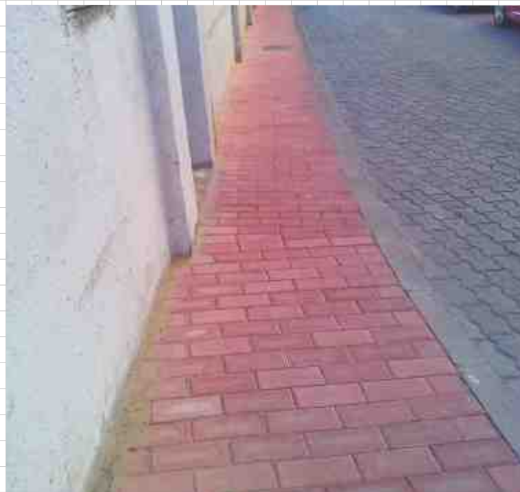
Sustitución de adoquines en la calle San Martín
