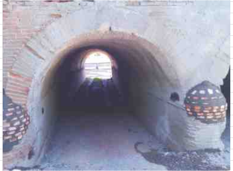
Obras en los puentes de la Carretera Mayorga - Hospital
