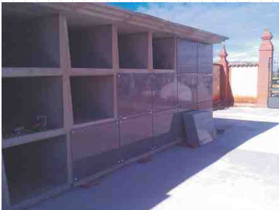
Construcción de nichos en el cementerio
