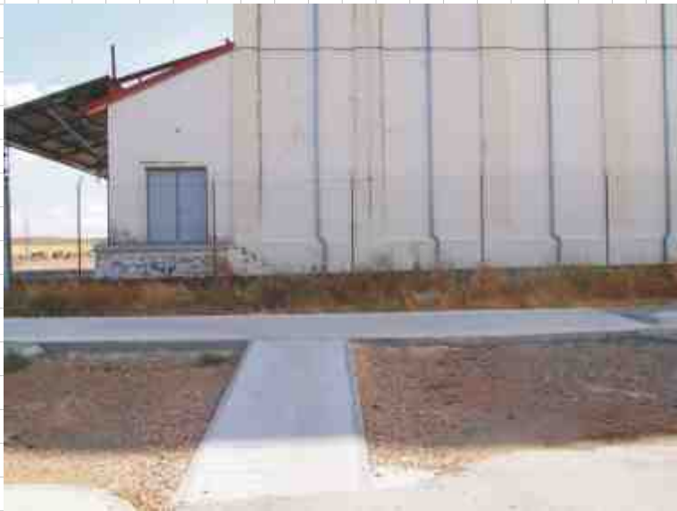
Acceso a la Vía Verde en el Silo
