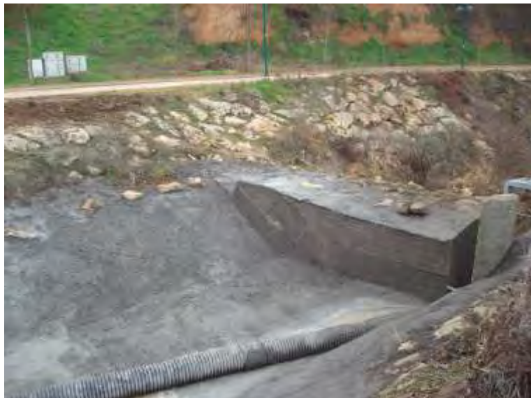
Reparación Azud Complejo de la Isla
