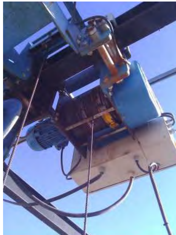
Estación de la depuradora remodelada
