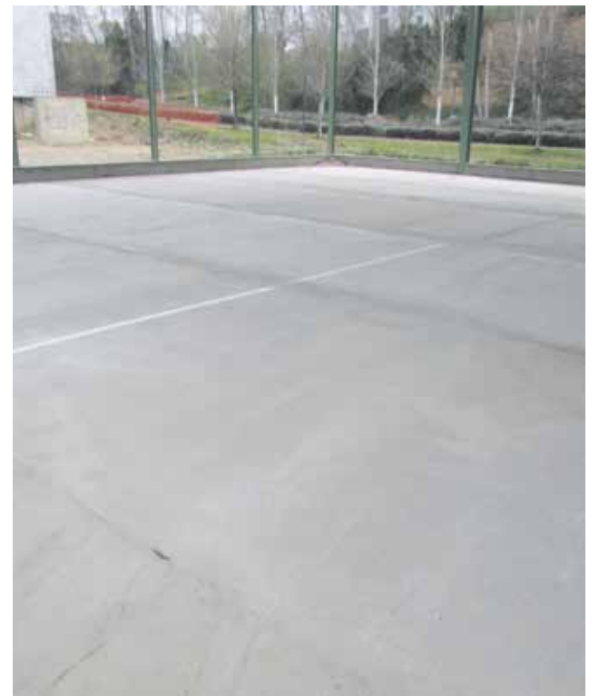
Pista de hormigón Pabellon Río
