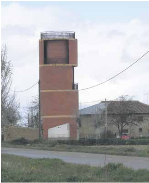
Limpieza Deposito del Agua (Cabañas)
