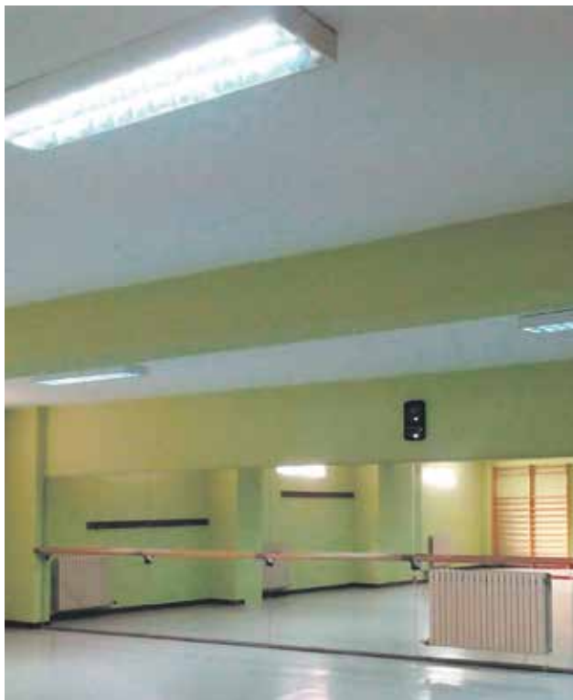
Pintura gimnasio (Casa de Cultura)
