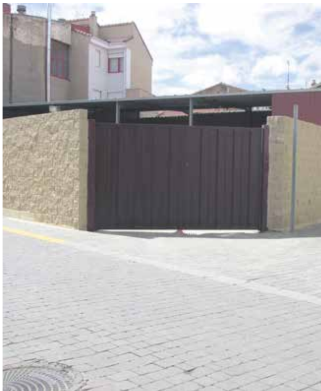
Valla y puerta del patio del Ayuntamiento
