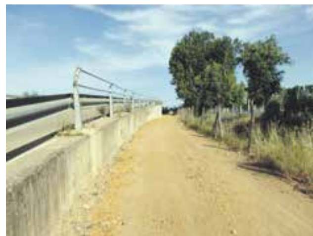
Reparación Camino Valencia-Camping
