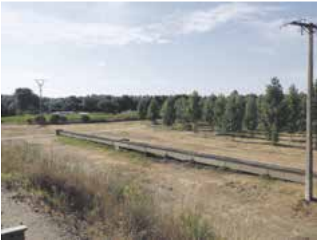
Acondicionamiento Aparcamiento Polideportivo Municipal
