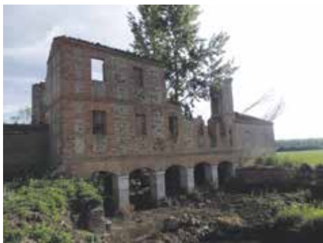
Obras limpieza antiguo Molino cedido por C.H.D.
