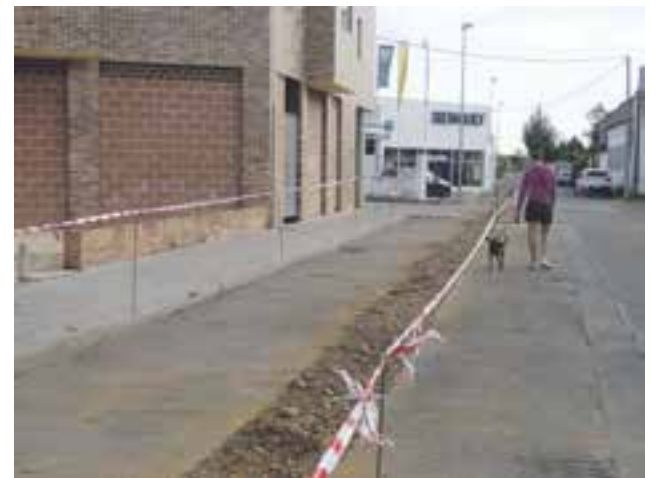
Comienzo obras Planes Provinciales 2005. Colector Los Juncasles
