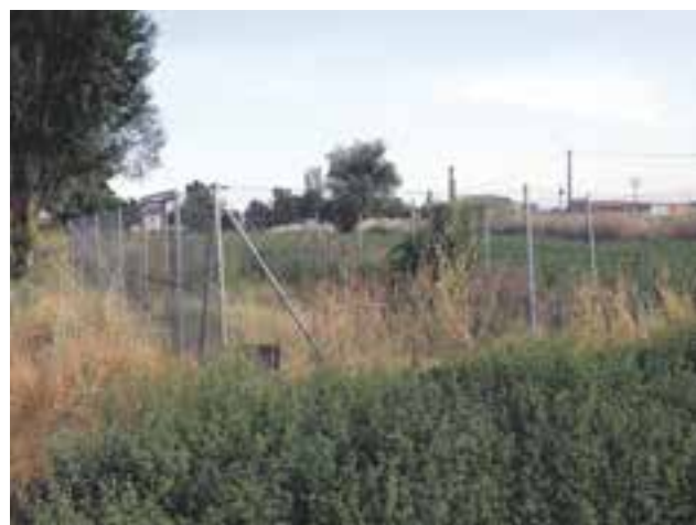
Reparación vallado Depuradora Cabañas y limpieza
