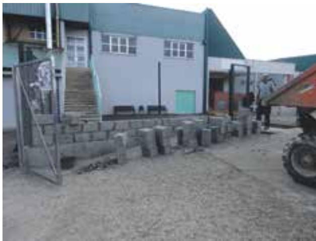
Comienzo de la construcción del nuevo vallado del Colegio
