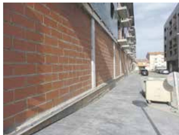
Nueva acera en Calle Academico Garcia Morejon
