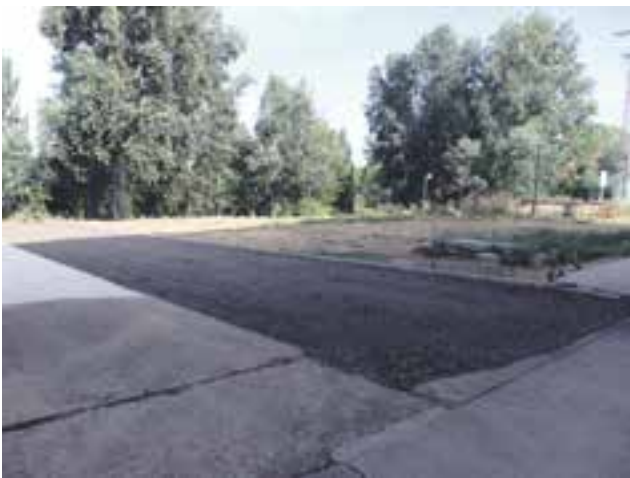
Comienzo construcción Parque Torre del Oro
