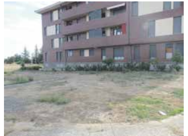
Comienzo construcción Parque Plaza de Toros
