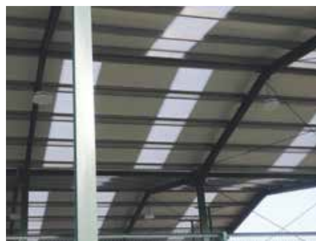
Nuevo alumbrado Pistas de Padel
