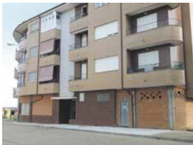
Reparación aceras Calle Alcalde Indalecio Perez
