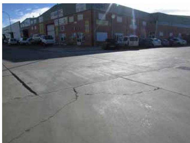
Reparación paños polígono industrial
