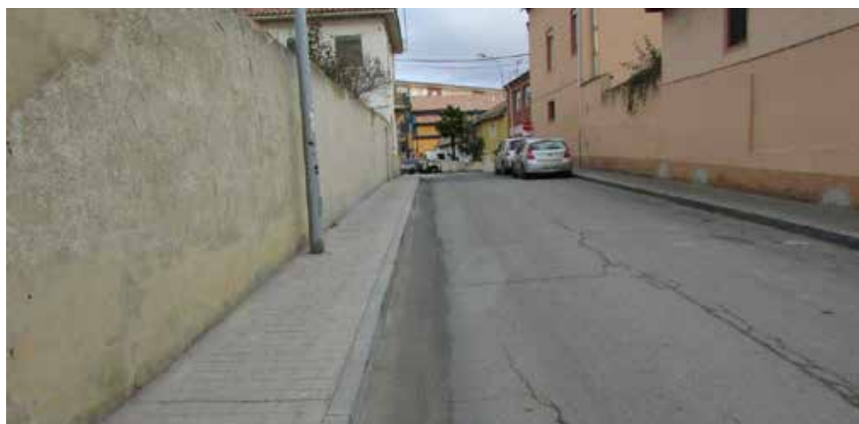
Sustitución red agua fibrocemento en Calle de los Rosales (2)
