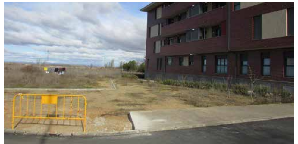
Comienzo de las obras parque Bellavista
