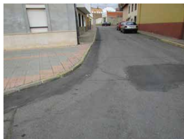
Sustitución red agua fibrocemento en Calle de los Rosales
