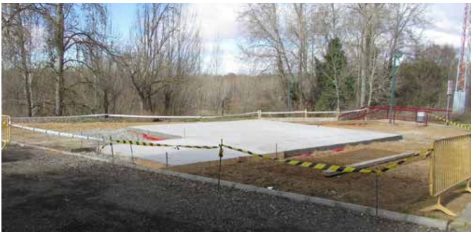
Comienzo de las obras en parque Torre del Oro
