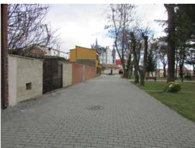
Sustitución red agua de fibrocemento en Calle Del Parque
