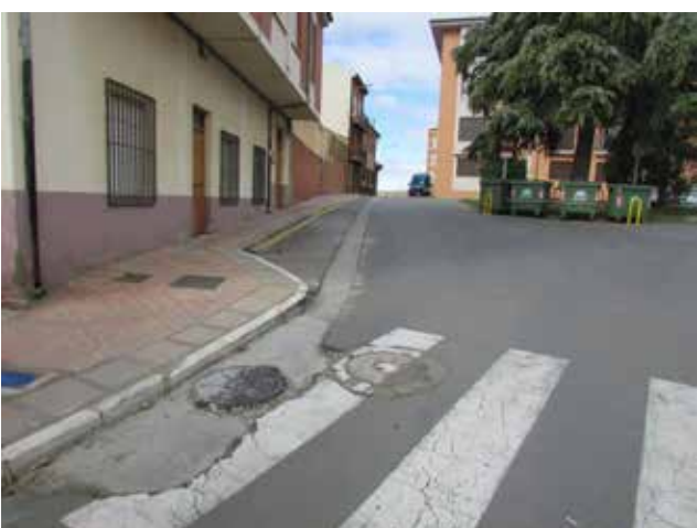
Sustitución red agua de fibrocemento en Calle Barrio Nuevo
