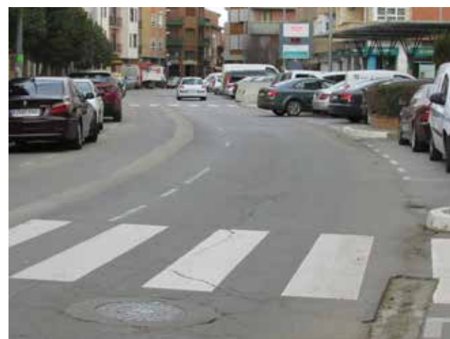
Sustitución red agua de fibrocemento en Calle de Carlos Pinilla
