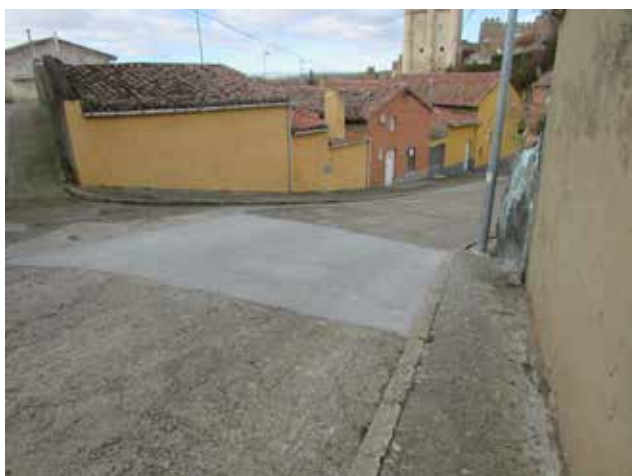
Reparación paño en Calle de la Fontana
