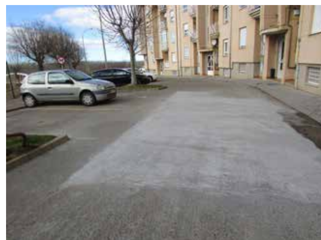
Reparación paños en C/ del Maestro Pastrana
