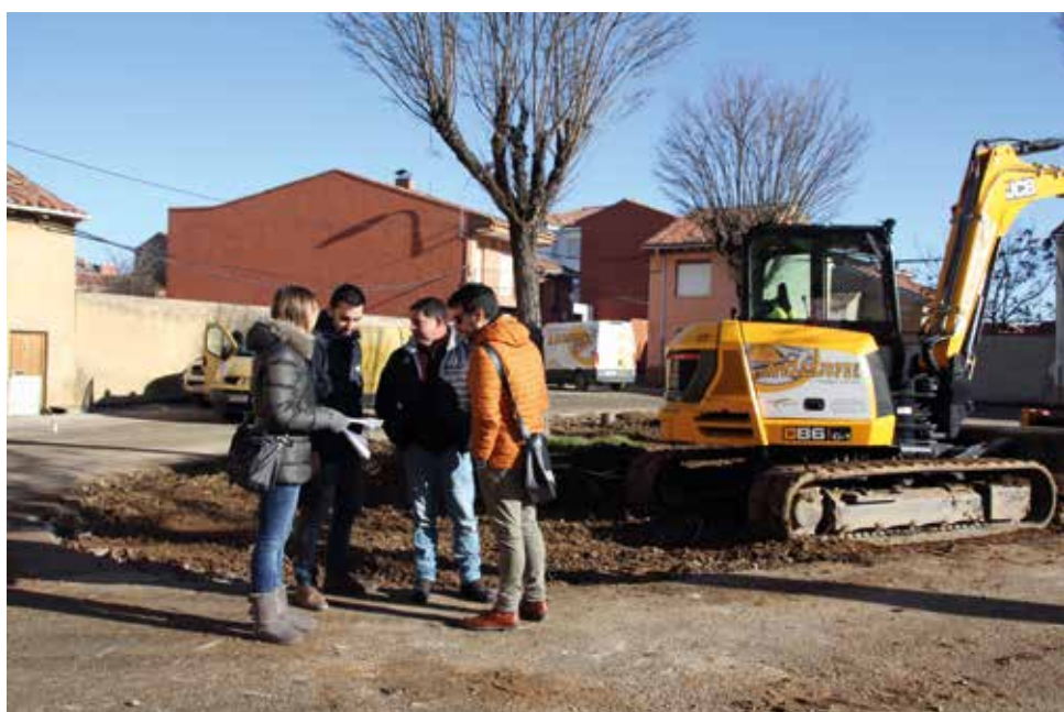
Comienza la remodelación de la plaza San Andrés. El objetivo es ganar espacio para los vecinos. Esas obras están incluidas en el Plan de Cooperación Municipal 2017 y cuenta con un presupuesto de 133.242 euros
