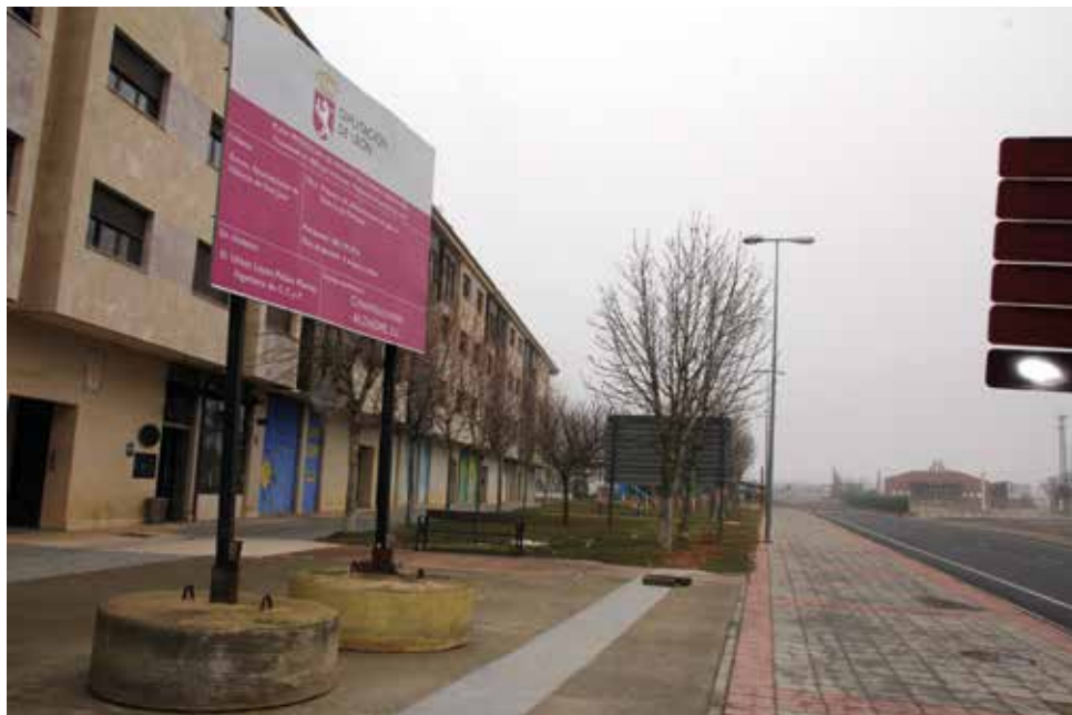
El Ayuntamiento acaba con el fibrocemento del municipio
