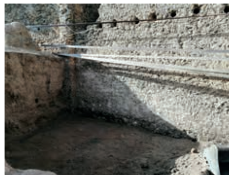
Proceso de excavación de la torre Noroeste (fin. s. XIV)
