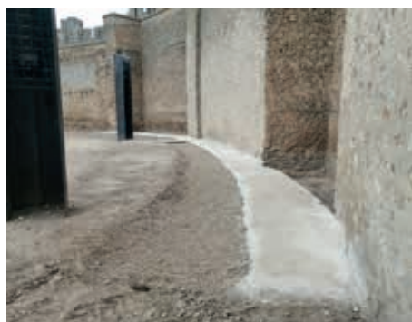
Protección final del muro de tapia plenomedieval
