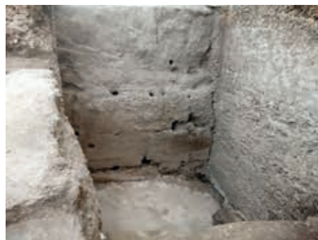
Muros de la torre Noroeste (fin. s. XIV)
