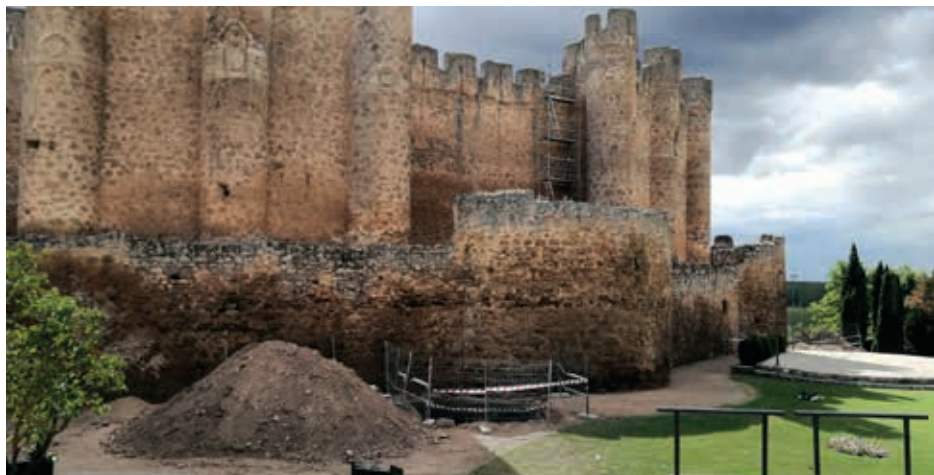
Vista general de las catas realizadas en el foso
